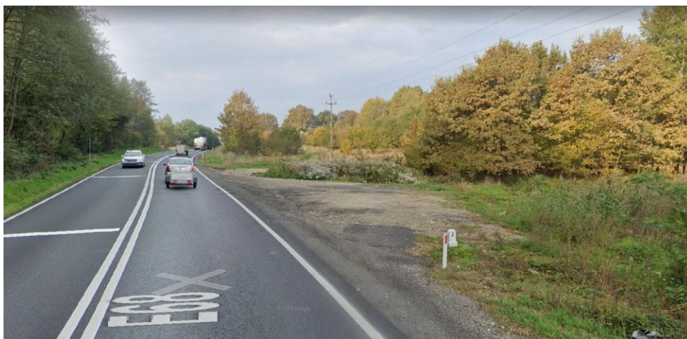
Fig. 2.33 SPAȚIU DE PARCARE, OPRIRE ȘI STAȚIONARE PE DN 1 DIN JUDEȚUL SIBIU (2022)
