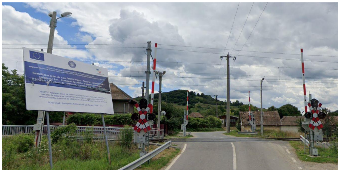
Fig. 2.23 INTERSECȚIE LA NIVEL CU INSTALAȚII AUTOMATE DE SEMNALIZATE RUTIERĂ CU SEMIBARIERE, LA INTERSECȚIA DJ 142F CU CF 300 (2022)
