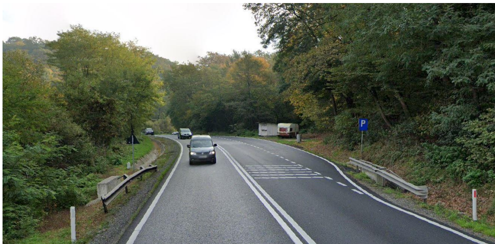
Fig. 2.32 SPAȚIU DE PARCARE, OPRIRE ȘI STAȚIONARE PE DN 1 DIN JUDEȚUL SIBIU (2022)
