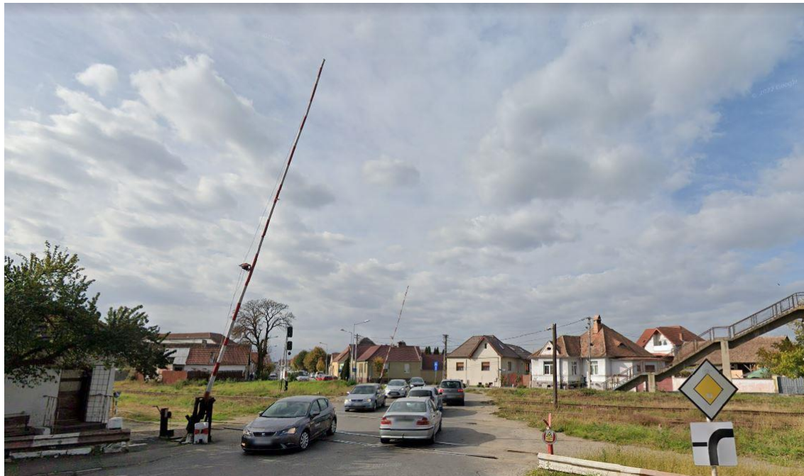
Fig. 2.22 INTERSECȚIE LA NIVEL CU BARIERĂ (CALEA TURNIȘORULUI – SIBIU) (2022)
